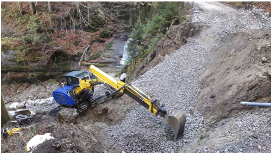
Im Mühltobel sanierte die Wildbach- und Lawinerverbauung das erste Teilstück mit einer Steinschichtung.
