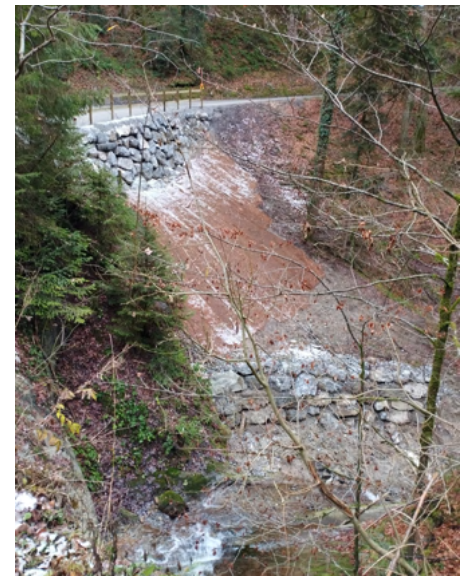
Im Mühltobel sanierte die Wildbach- und Lawinerverbauung das erste Teilstück mit einer Steinschichtung.
